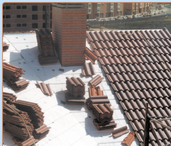
Colocación de teja
