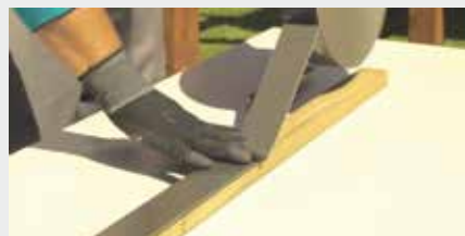
Instalación cinta adhesiva bajo listón
