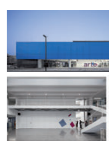
XII EDICIÓN PREMIO DE ARQUITECTURA DE LADRILLO 2011-2013 40
