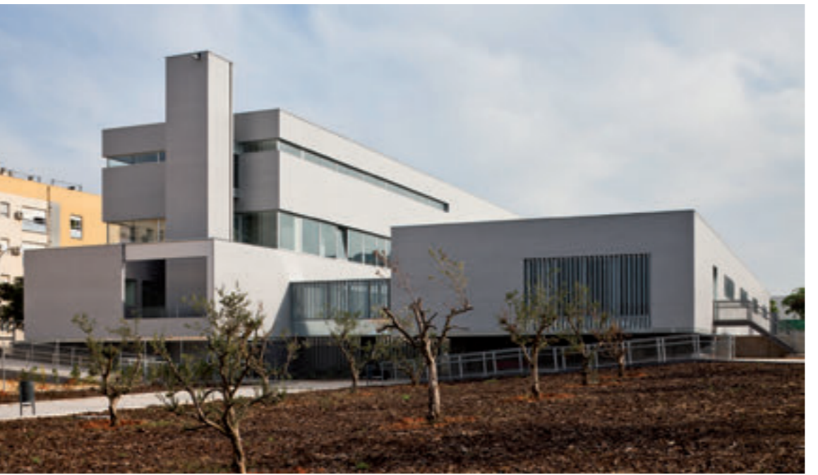
XII EDICIÓN PREMIO DE ARQUITECTURA DE LADRILLO 2011-2013 45
