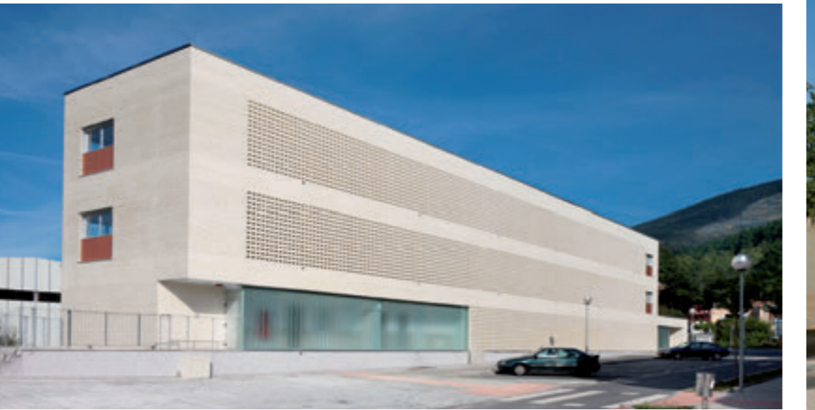
XII EDICIÓN PREMIO DE ARQUITECTURA DE LADRILLO 2011-2013 47
