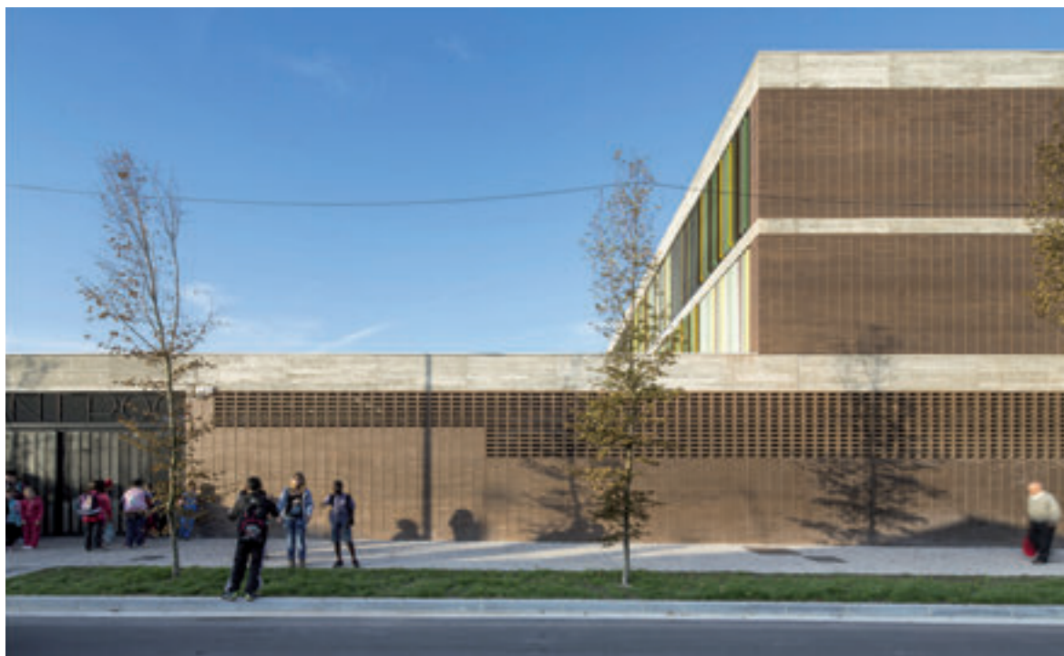
XII EDICIÓN PREMIO DE ARQUITECTURA DE LADRILLO 2011-2013 43
