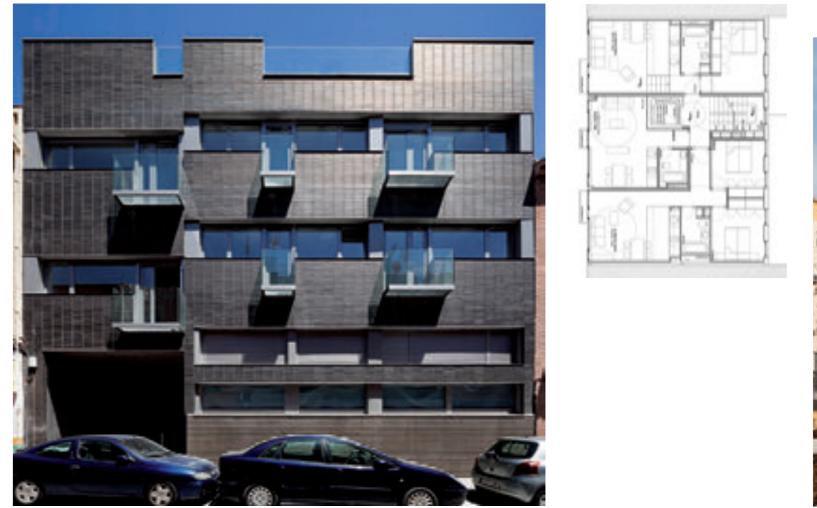
44 XII EDICIÓN PREMIO DE ARQUITECTURA DE LADRILLO 2011-2013
