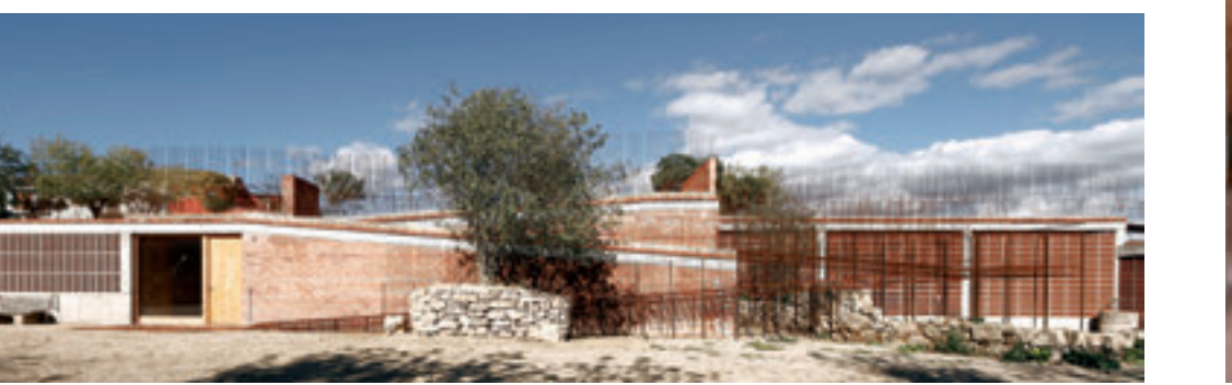
28 XII EDICIÓN PREMIO DE ARQUITECTURA DE LADRILLO 2011-2013
