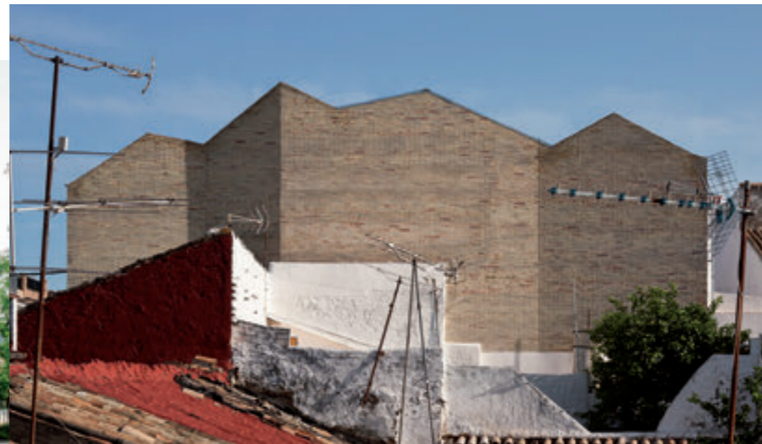
XII EDICIÓN PREMIO DE ARQUITECTURA DE LADRILLO 2011-2013 37
