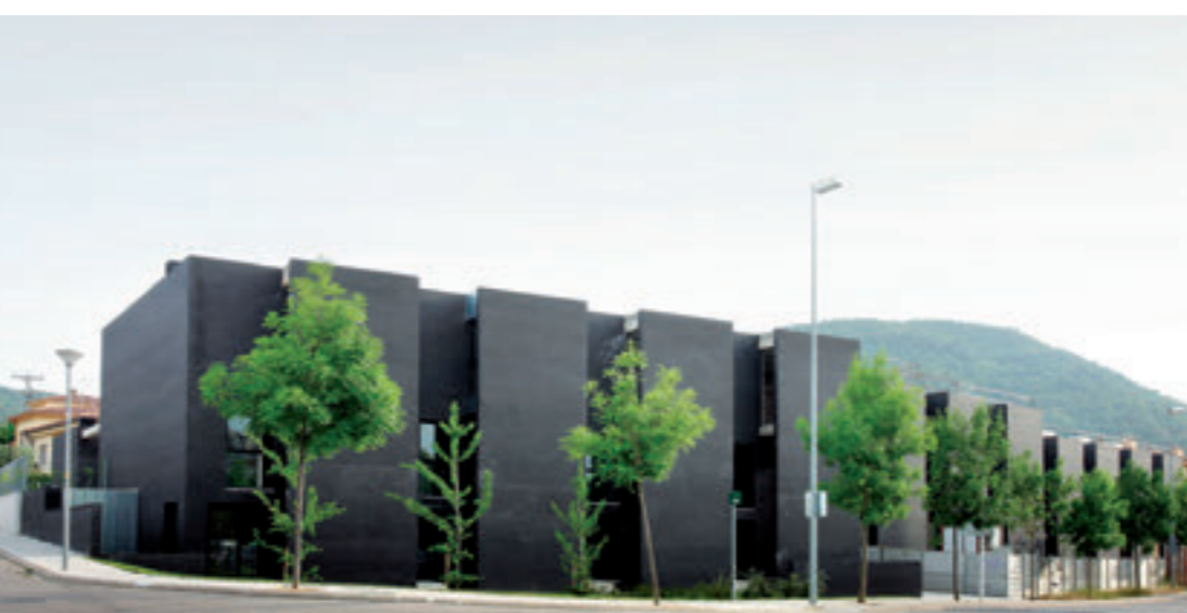
XII EDICIÓN PREMIO DE ARQUITECTURA DE LADRILLO 2011-2013 36
