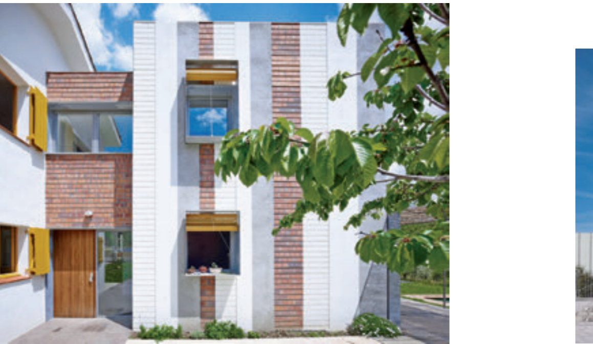
46 XII EDICIÓN PREMIO DE ARQUITECTURA DE LADRILLO 2011-2013
