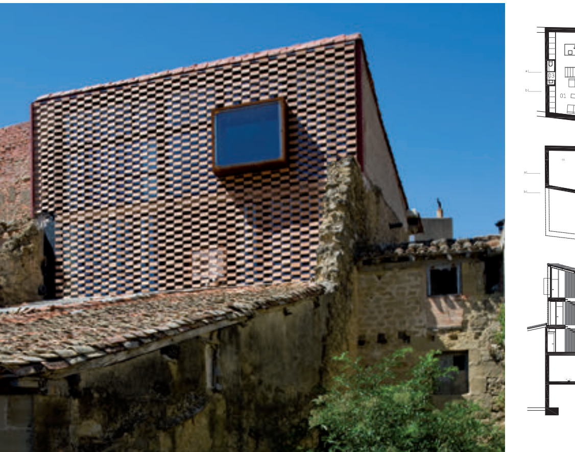
XII EDICIÓN PREMIO DE ARQUITECTURA DE LADRILLO 2011-2013 31
