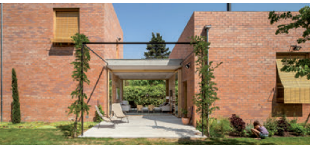
32 XII EDICIÓN PREMIO DE ARQUITECTURA DE LADRILLO 2011-2013
