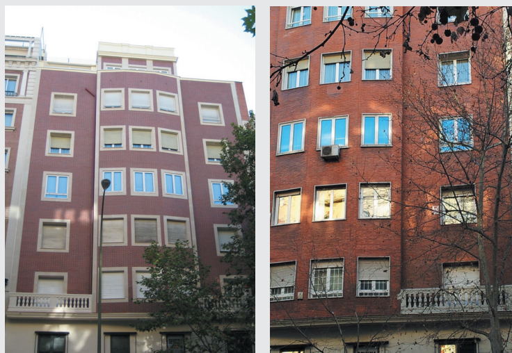
Rehabilitación de fachada en c/ Velázquez 60, Madrid
