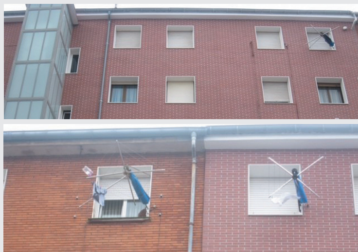
Rehabilitación de fachada en c/ Jose Zorrilla 8, Barakaldo (Vizcaya) Arquitecto: Arriazu & Garay, S.L.P. (Eduardo Garay Fuentes)
