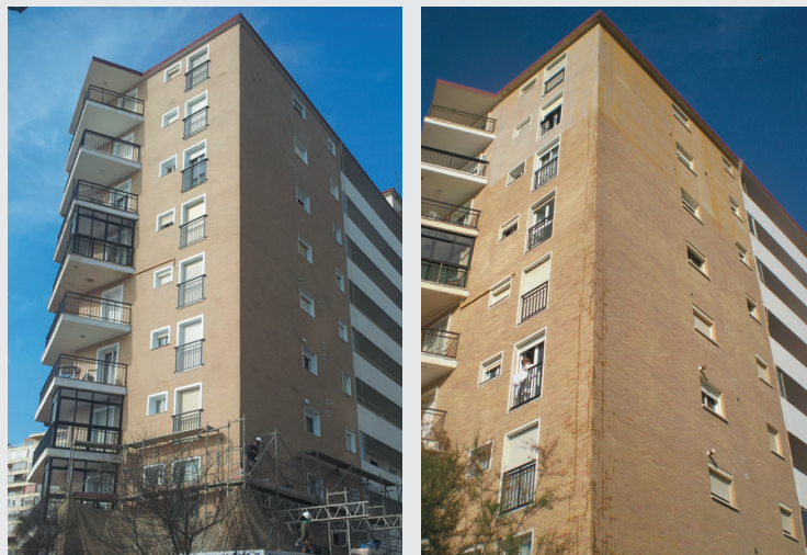
Rehabilitación Edificio Ronda 2 – Fuengirola (Málaga) Arquitecto: Fernando Recio Garcé
