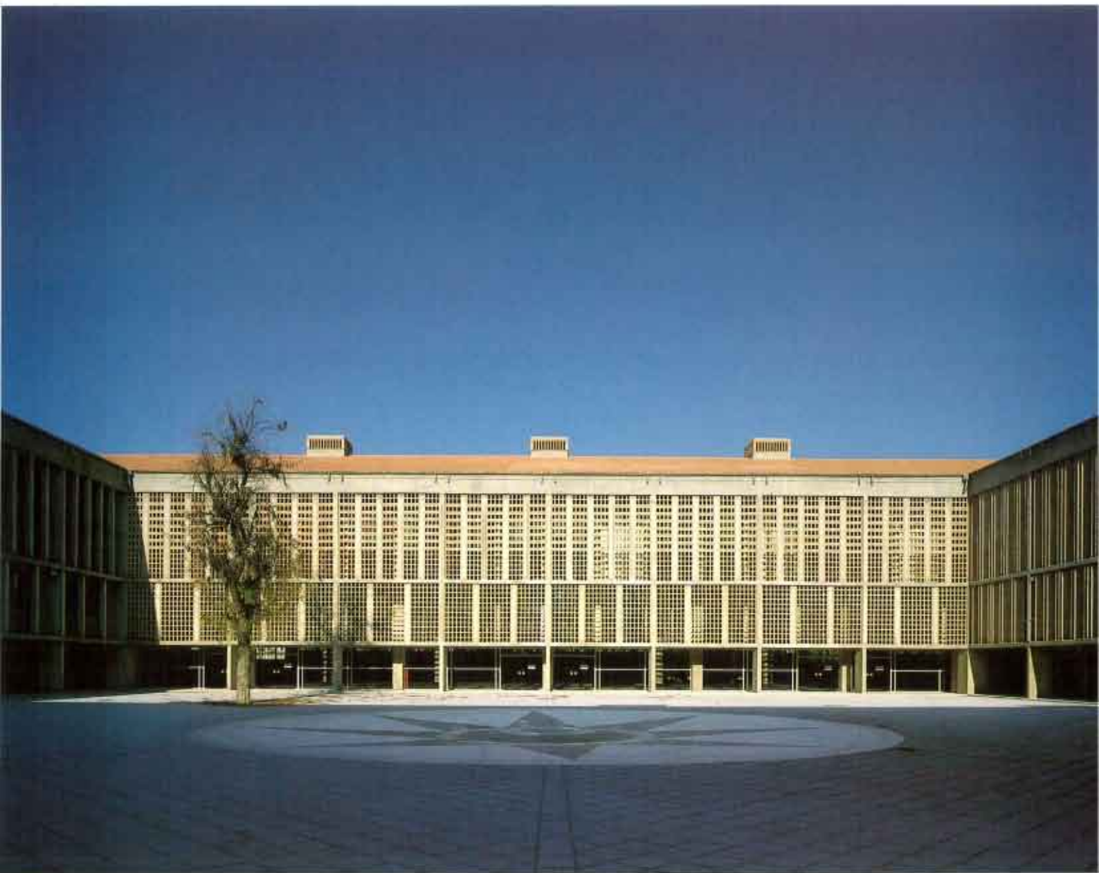
Plaza central: Fachada Suroccidental, Suroccidente (parterre) y Suroccidente
