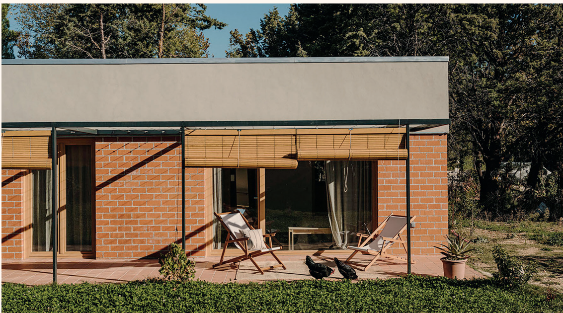
Figura 12. Fachada ladrillo cara vista. Casa Pedrezuela, Slow Studio
