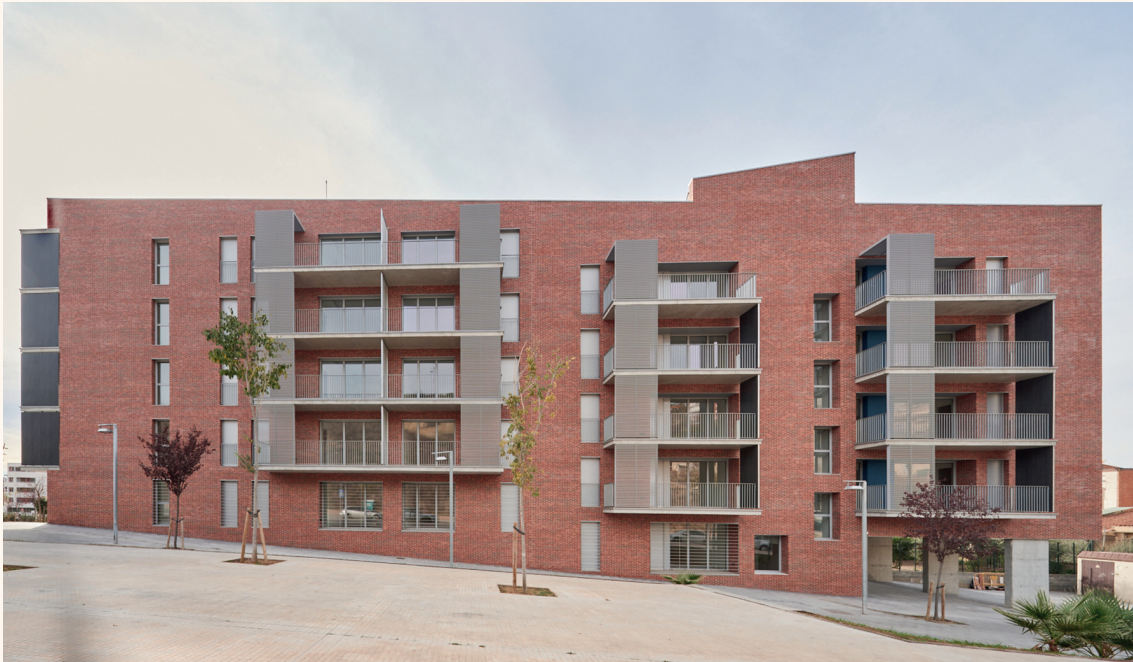
Figura 7. Fachada autoportante. 117 viviendas en Molins de Rei. Joan Pascual, Ramón Ausio y Cristóbal Fernández
