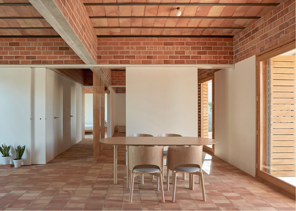
Figura 23. Bovedillas cerámicas y particiones interiores con ladrillo para revestir. Casa en Bétera, Hugo Mompó y Juan Grau
