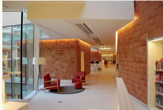
Figura 13. Particiones interiores con bloque Termoarcilla. Biblioteca Sant Gervasi. Joan Maragall, BCQ Arquitectura
