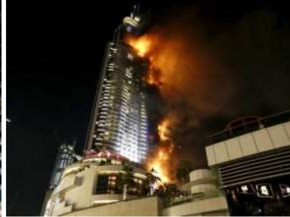
Edificio Saif Balhasa (12 plantas) 06/10/2012
