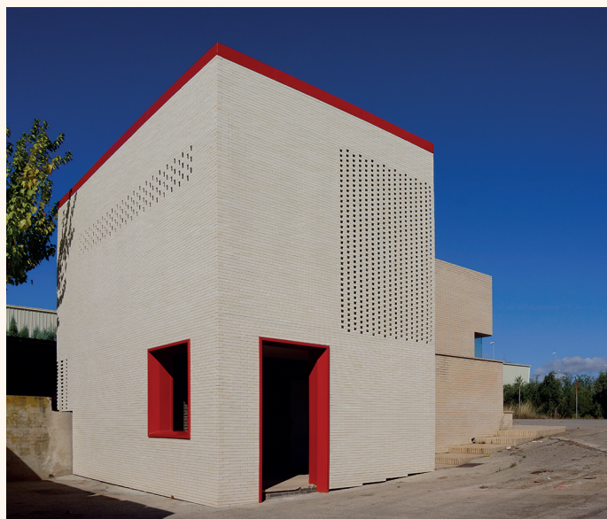
Figura 9. Fachada ejecutada con sistema Cablebrick de Cerámica Malpesa.
