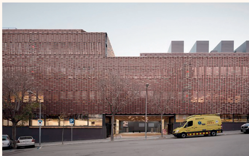
Figura 13. Instituto de Investigación del Hospital de Sant Pau, Barcelona. Pich Aguilera Arquitectes y 2BMFG Arquitectos. Fotografía Aldo Amoretti.
