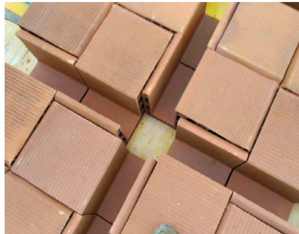
MÓDULO DE 4 PIEZAS SISTEMA CRECE EL CRUCE DE NERVIOS SE ALOJA EN EL CENTRO DE CADA MÓDULO
