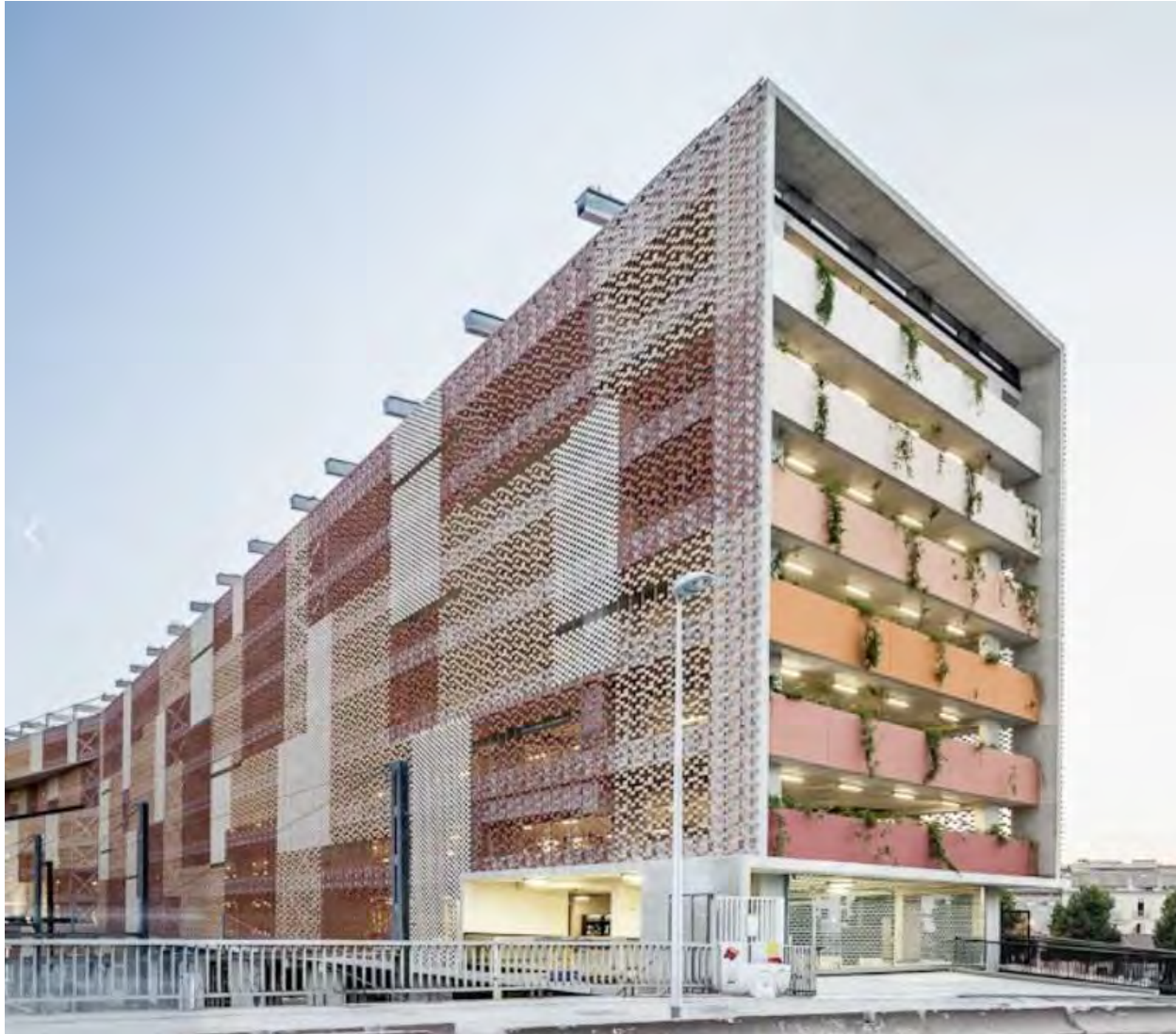
APARCAMIENTO SAINT ROCH-MONTPELLIER. Archikubik Studio
