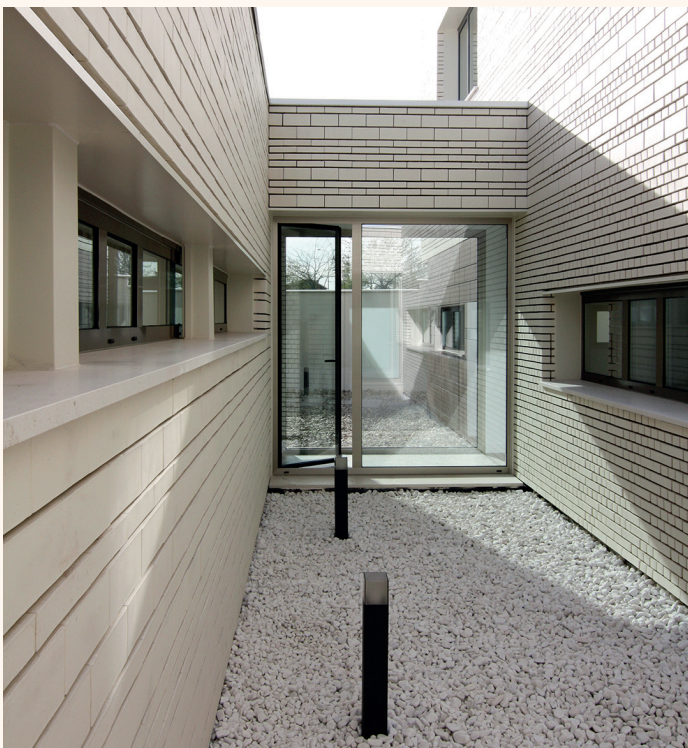
Figura 7. Vivienda en Señorío de Illescas, Illescas (Toledo). Toral Arquitectos
