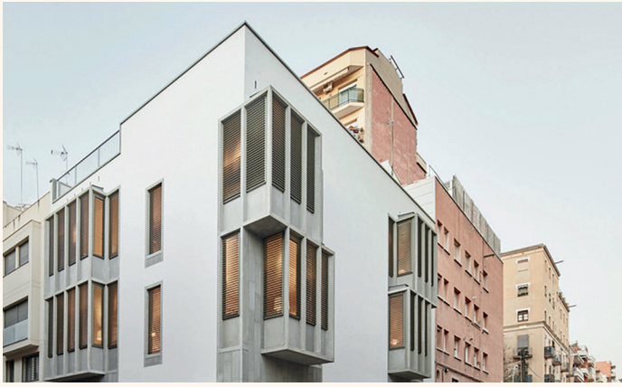
Figura 6. Bloque de viviendas en Barcelona, con cerramiento de bloque cerámico aligerado revestido con un sistema SATE. Arq. Raimon Farré Moretó. Foto: José Hevia
