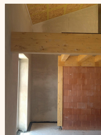
Figura 6. Fachada muro carga bloque Termoarcilla vista desde el interior en CTL Pasiva Positiva.
