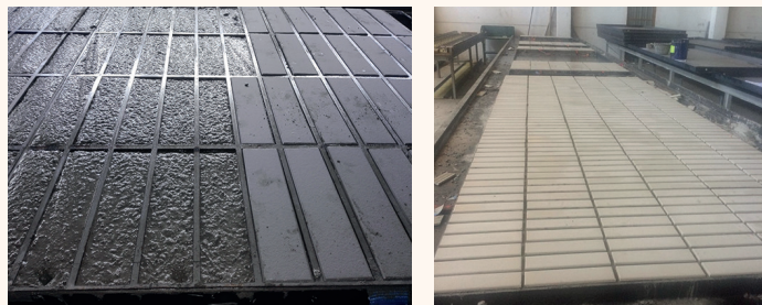
Figura 4. Colocación de plaquetas cerámicas y pieza INSUPANEL acabada
