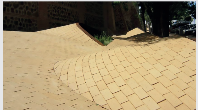
Figura 2: Adoquines cerámicos de alta reflectancia. Fuente: Hispalyt.
