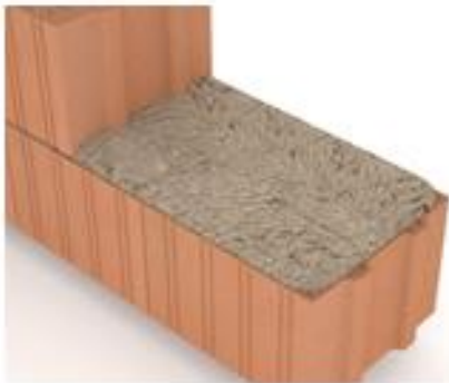
Montaje 1: Junta horizontal de mortero continua
