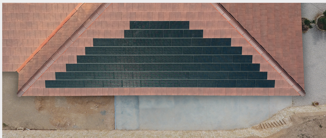
Figura 6: Teja Solar Fotovoltaica Planum.
