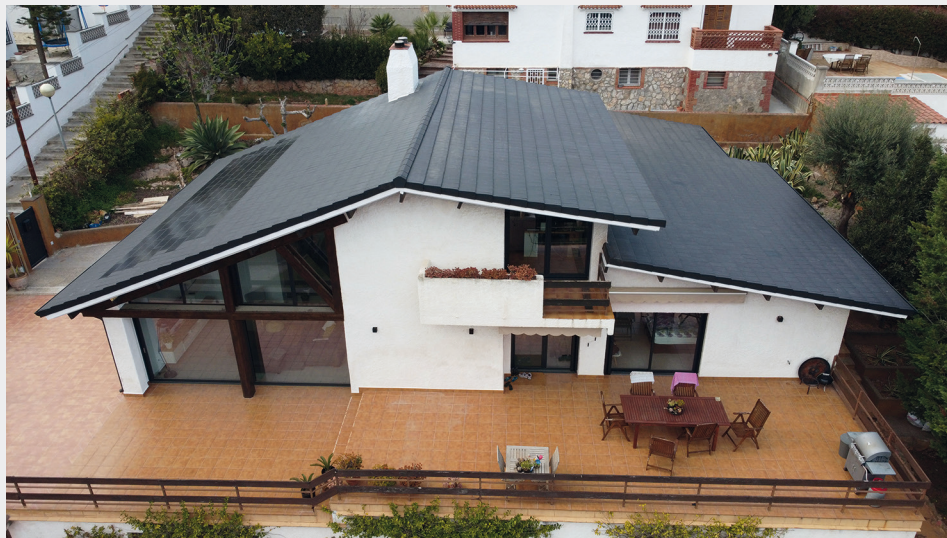
Figura 5: Sistema Solar Fotovoltaico Planum con teja Planum Pizarra klinker.
