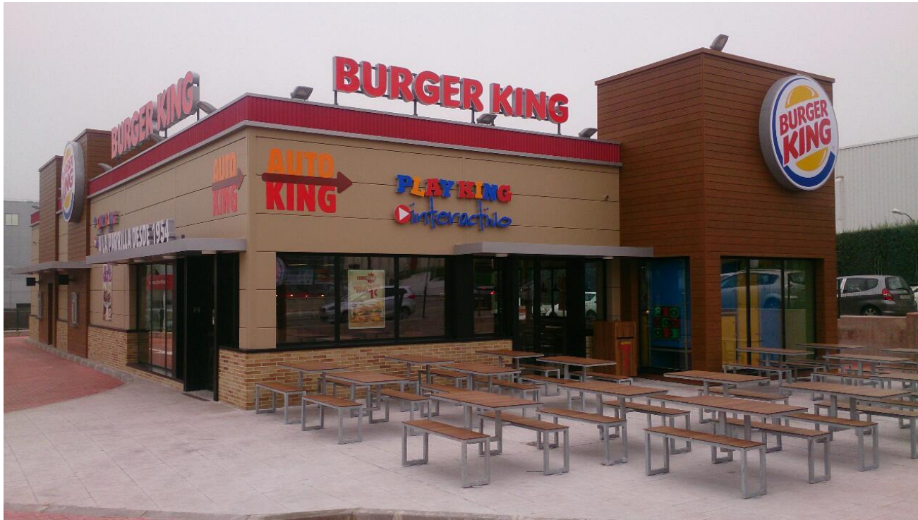
MADRID – Construcción industrializada Burger King
