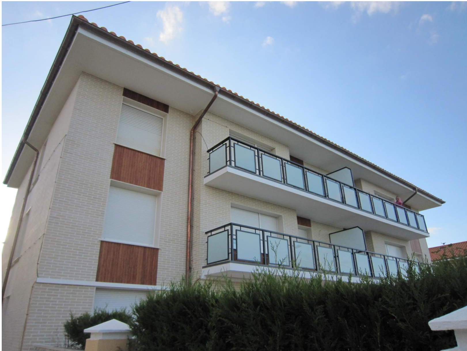
Lequeitio – Rehabilitación en Lequeitio
