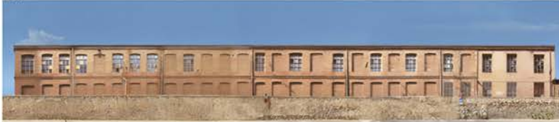
1905-2008 estado previo de la fachada de la nave
