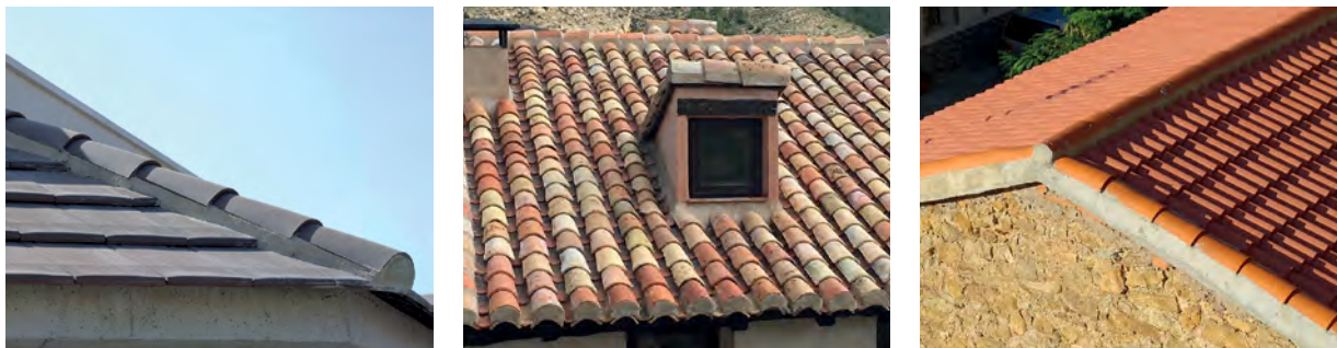
Figura 11. Ejemplos de cubierta tradicional con fijación de las tejas con mortero
