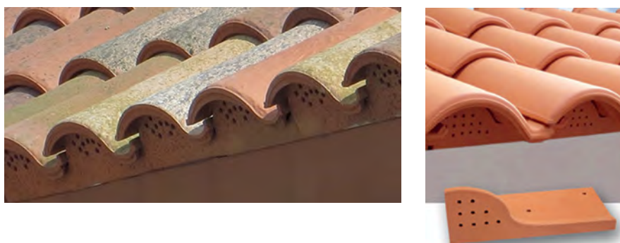
Figura 56. Aleros con barrera de pájaros para permitir la entrada de aire de la microventilación
