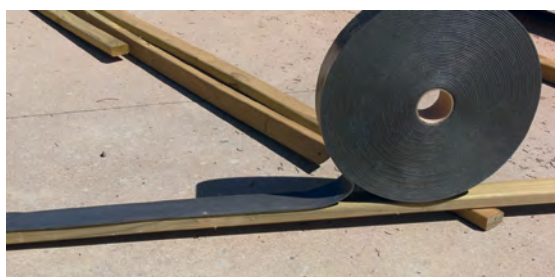
Figura 47. Colocación de cinta adhesiva en listones
