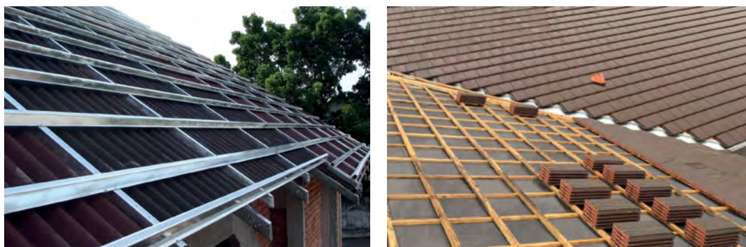
Figura 45. Tipos de rastreles de diferentes materiales
