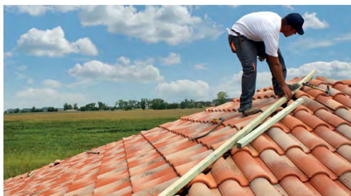
Figura 76. Rastrel de limatesa sobre soporte
