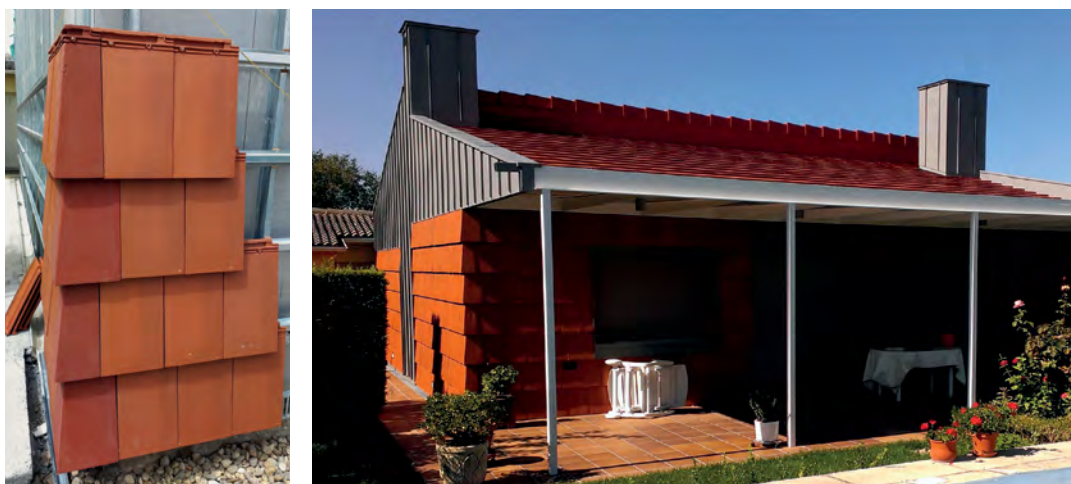
Figura 39. Fachada ventilada de teja cerámica
