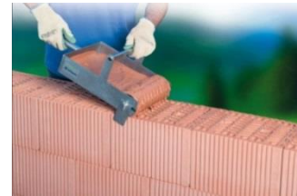
Terminoarcilla ECO3 con celdillas romboidales
