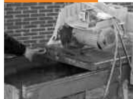
Realización de corte de un adoquín cerámico con mesa cortadora
