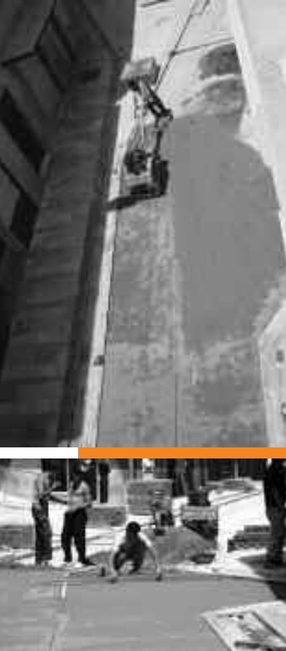
Compactación de la capa de arena
