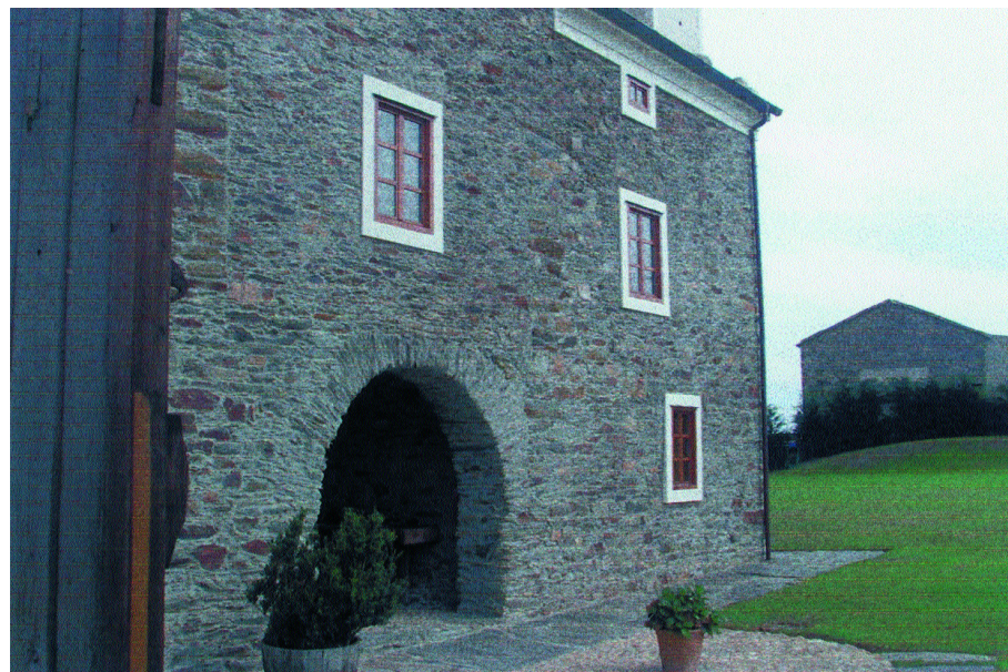
Muro de piedra
